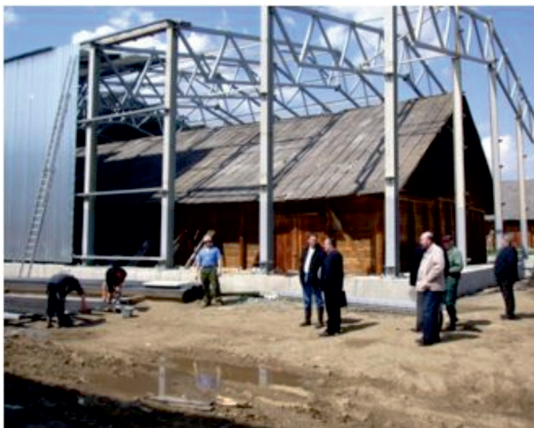
Рис. 13. Возведение металлического ангара над деревянным хранилищем ториеносных песков, Красноуфимск [16]
